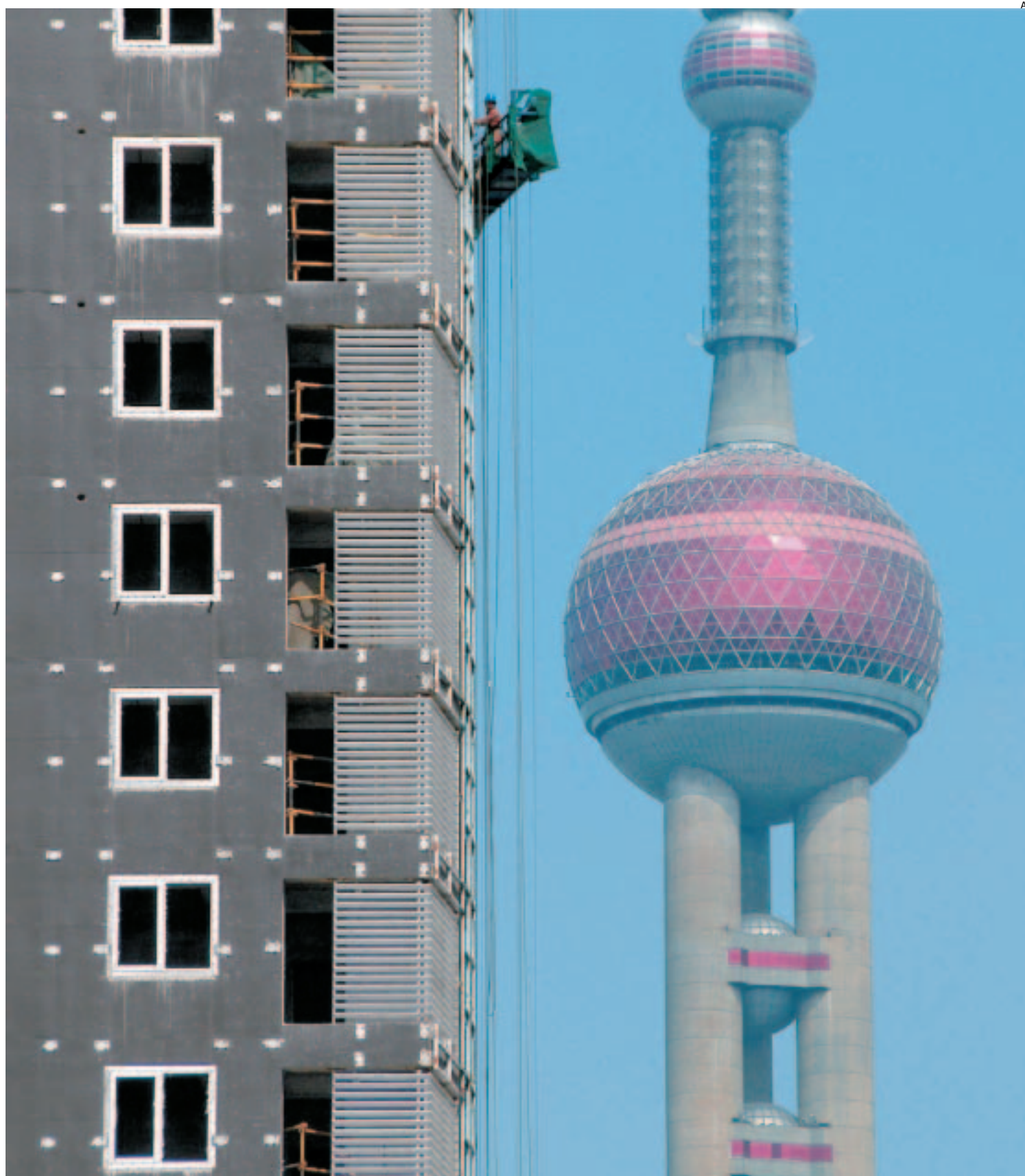
Operários chineses trabalham na construção de um prédio residencial em Xangai, ao lado da Oriental Pearl Tower; venda de apartamentos dispara no país
